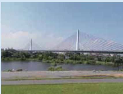
写真■菅原城北大橋
