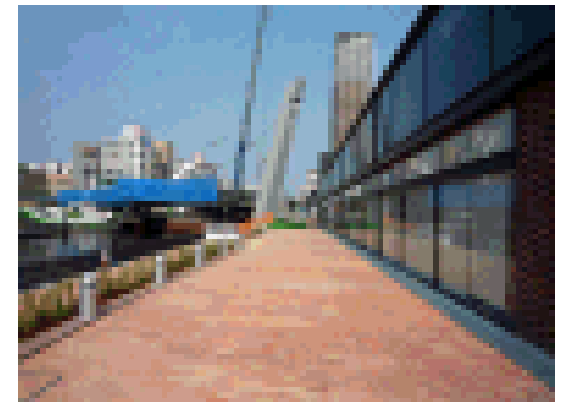
現地の状況(西区側上流より)
