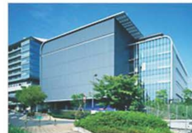
(出典: NRI 横浜第二データセンター)
