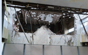
道の駅高田松原(内部)
