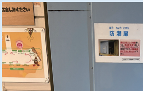
水族館が地下にあるため防潮扉が 設置されている
