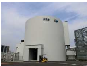
多目的大型実験棟
