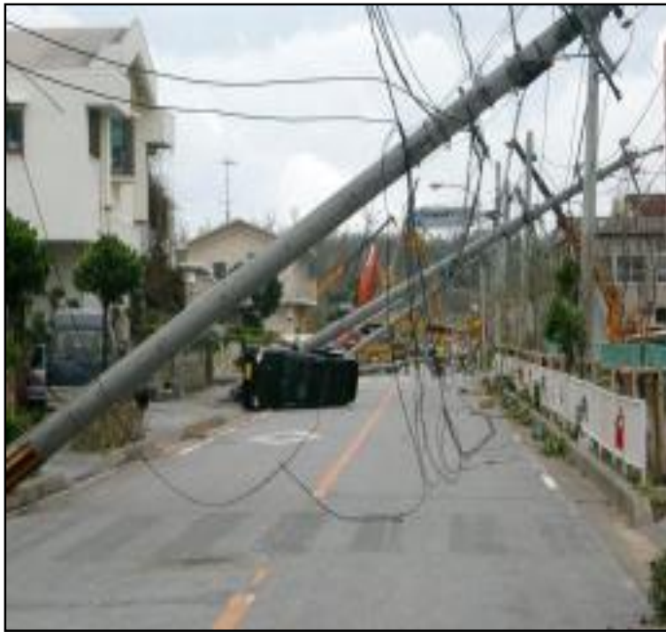
でんちゆう たお 電柱が 倒れる
