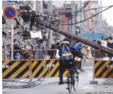
阪神淡路大震災 被災状況(1995年) (出典:国土交通省HP)
