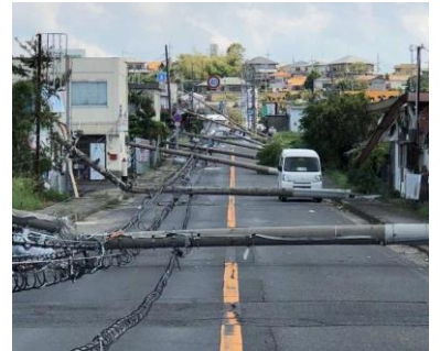
台風21号 被災状況(2018年) (大阪府泉南市)
