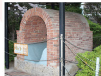
▲実際に明治時代に使われていたレンガ造りの下水道管です
