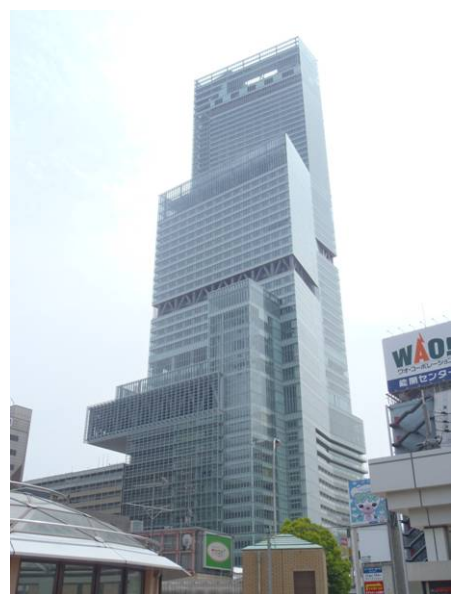
写真⑥ 施設全景
