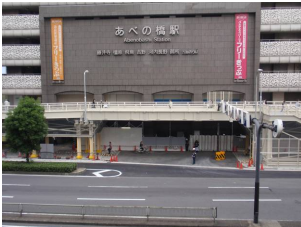
写真① 北側出入口の状況
