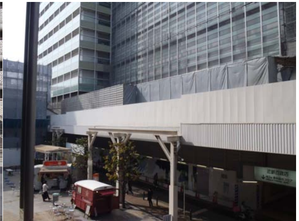
写真② 騒音対策状況
