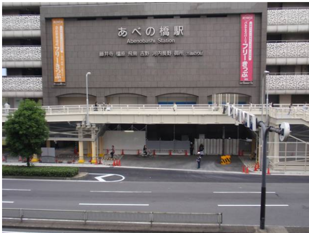
写真① 工事中の北側出入口の状況
