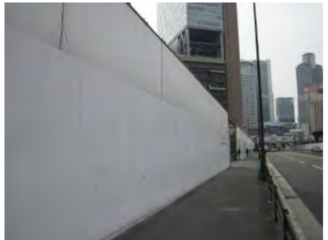
写真2：仮囲い設置状況
