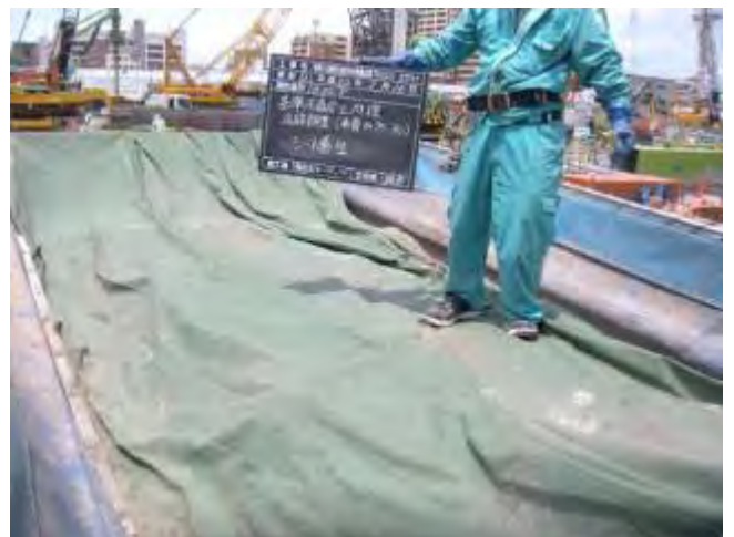
写真6：不適合土シート掛け状況
