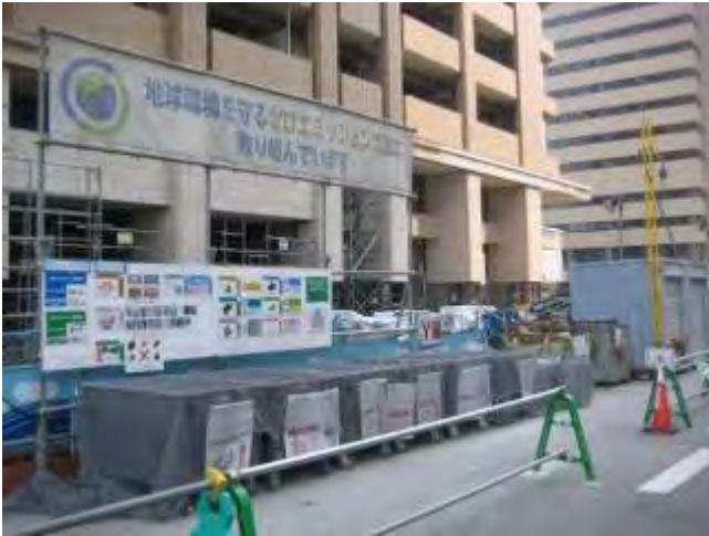
写真7：廃棄物専用ヤード設置状況
