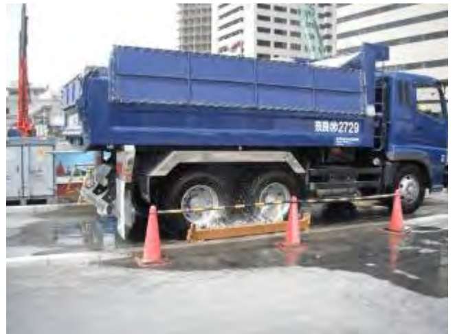
写真4：タイヤ洗浄状況
