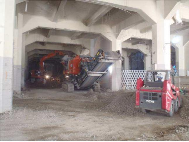
写真7 自走式破砕機による小割碎石再生状況
