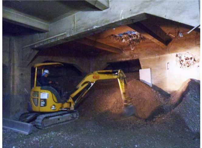
写真8 小割碎石による埋戻しの状況
