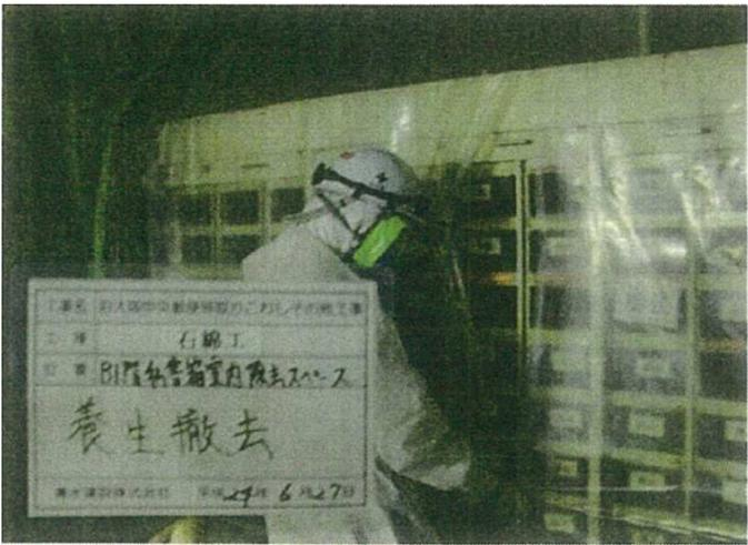
写真4 石綿除去工事の状況
