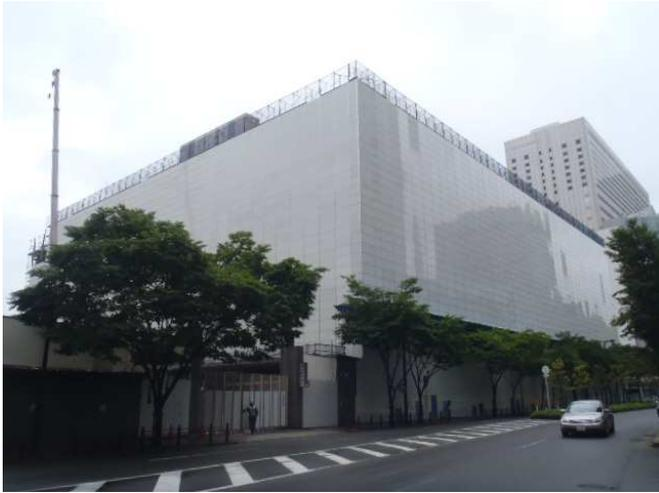
写真1 仮囲い、防音パネルの設置状況
