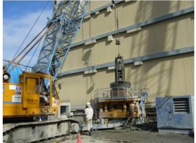
写真 14 地中障害物撤去（全旋回工法）
