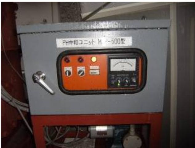
写真3 排水設備 PH 管理装置
