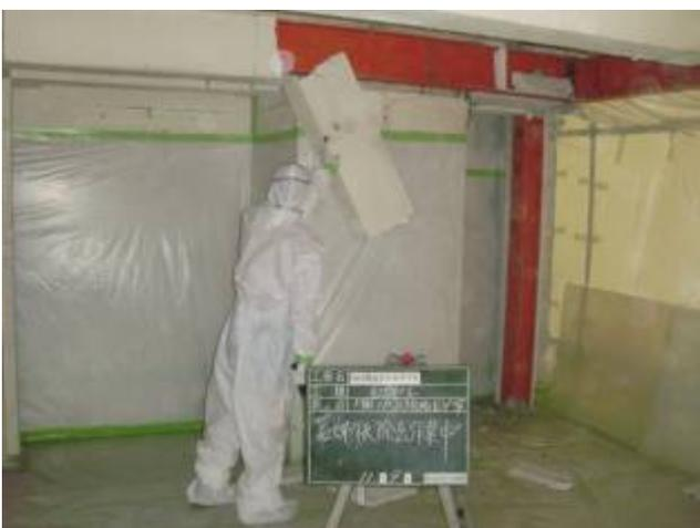
写真 17 アスベスト撤去工事
