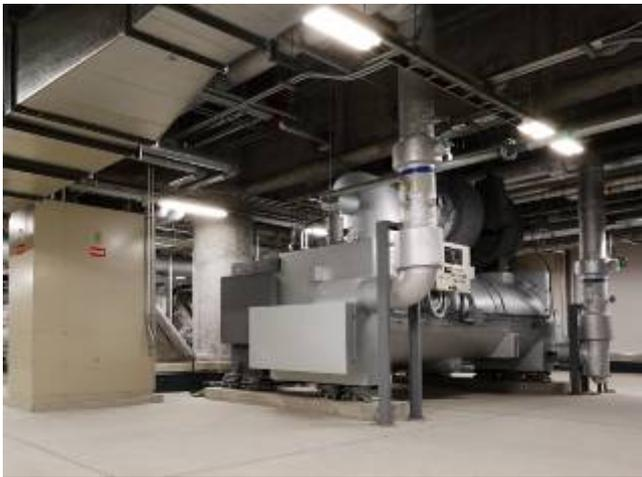
写真9 高効率熱源機器 (防振架台上に設置)
