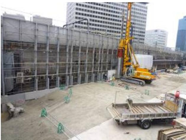
写真 15 地中障害物撤去（BG 工法）
