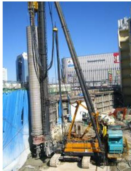
写真6 SMW 遮水壁工事の状況
