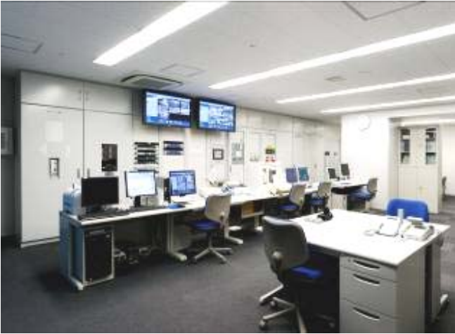
写真 10 中央監視装置（BEMS 見える化）
