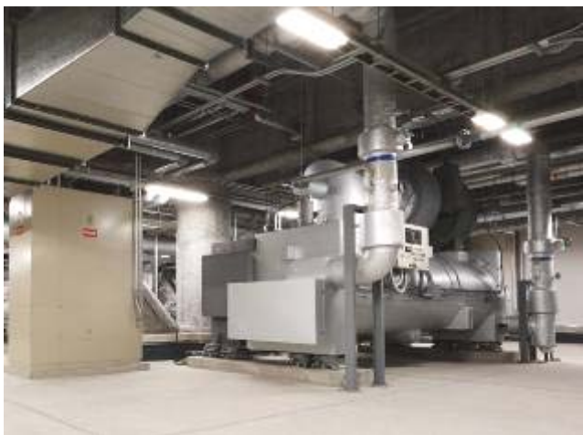
写真1 高効率熱源機器（防振架台上に設置）
