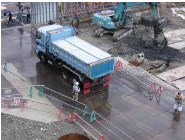
写真5 上蓋付き汚泥搬出車両とタイヤ洗浄 (車両による粉じんの飛散防止)
