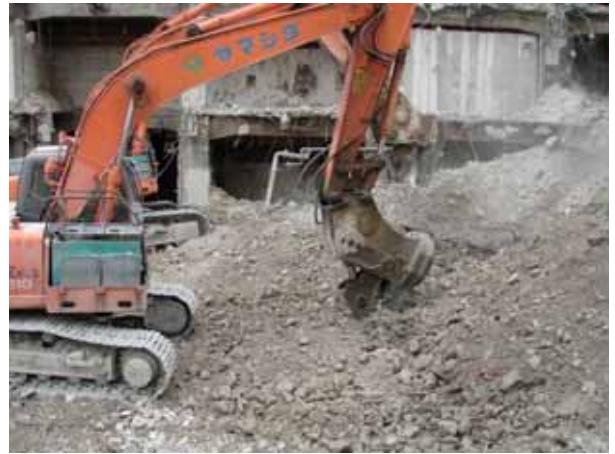
写真10 解体工事でのガラ小割り (廃棄物の抑制)
