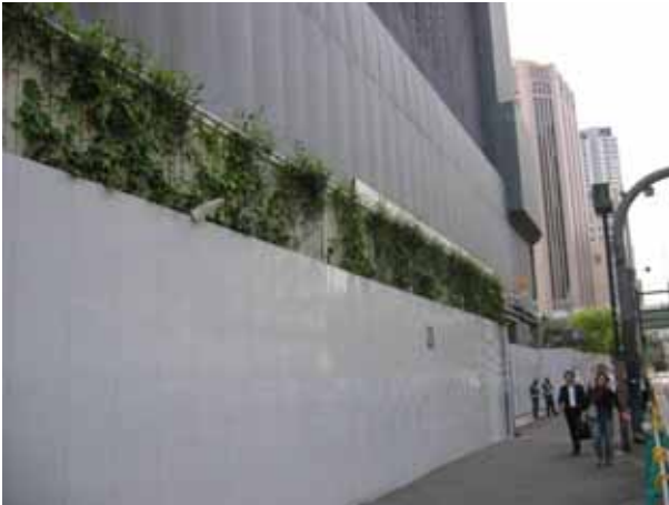
写真1 仮囲い(鋼鉄 3.0m + シート 1.2m)及び 上部緑化(親緑性への配慮)
