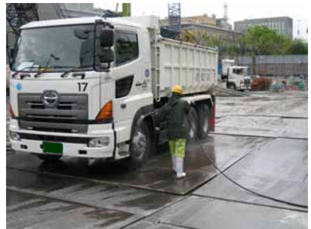
写真4 タイヤ洗浄 (タイヤへの泥土等の付着の回避)
