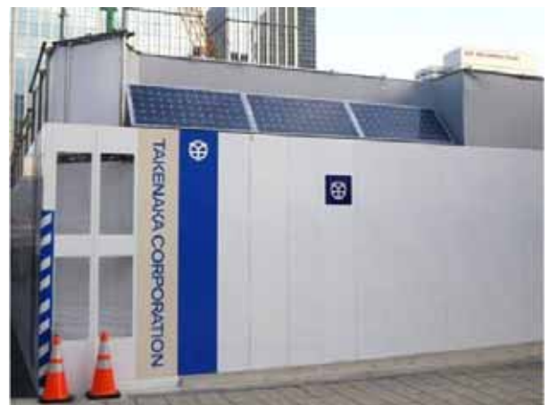
写真6 太陽光発電設備の設置 (CO 2 の削減)
