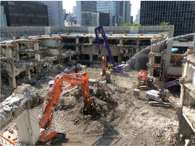
写真3 解体時状況写真（外壁内での解体）
