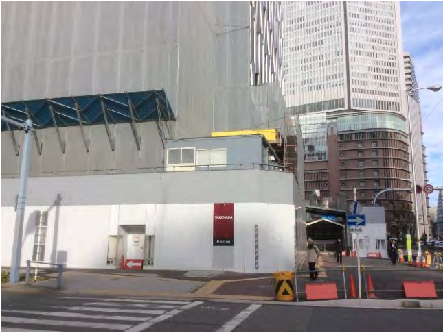
写真1 仮囲いの設置状況
