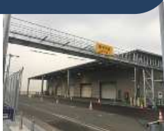
（高圧水素配管）
