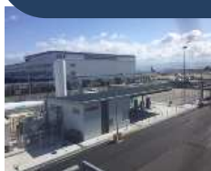
（水素ガスヤード全景）
