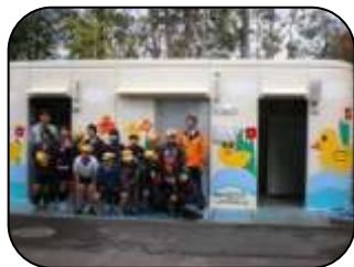
カラフルな配色で明るいトイレに
