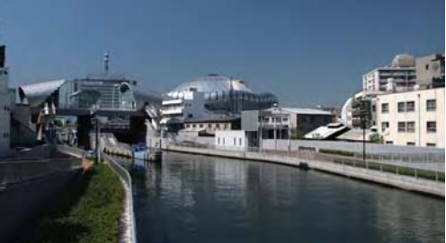
道頓堀川水門
