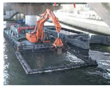
■浚渫(しゅんせつ)の様子
