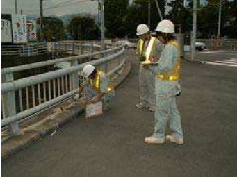
(参考) 橋面の点検状況イメージ
