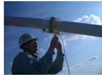
ケーブルの非破壊調査
