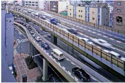
新御堂筋線高架橋
