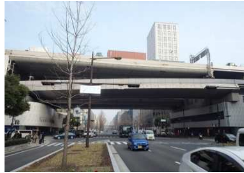
船場高架橋（御堂筋跨道橋）
