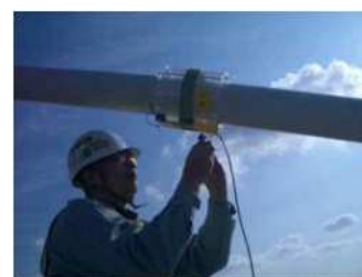
ケーブルの非破壊調査
