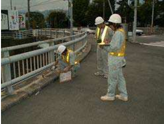
(参考) 橋面の点検状況イメージ
