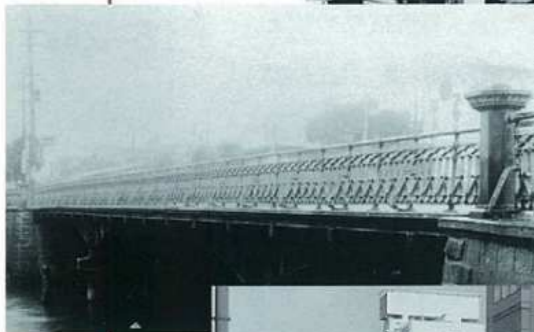
明治45年架け換えられた鉄橋
