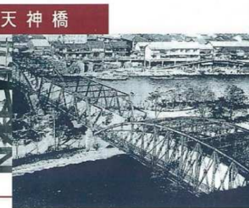
明治18年の淀川大洪水のあと、明治21年に架け換えられた鉄橋。
