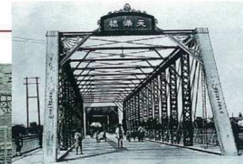
明治18年の淀川大洪水のあと、明治21年に架け換えられた鉄橋。
