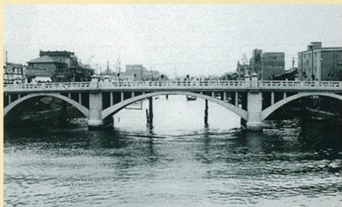
高麗橋 （昭和4年） 明治3年に大阪で最初の鉄橋として架け換えられたが、昭和に入って今の鉄筋コンクリートアーチ橋に変わった。古風な擬宝珠高欄が有名。
