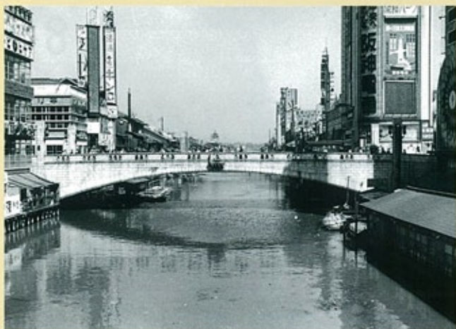
戎橋（大正14年） 道頓堀川に映えるコンクリートのアーチ橋。街の繁栄のシンボリック的存在となっている。
