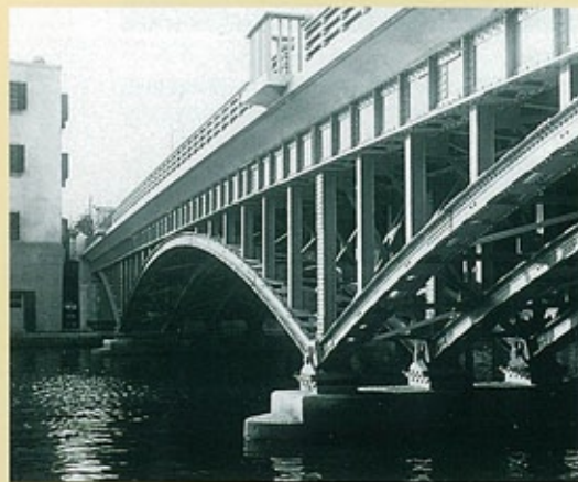
平野橋 （昭和10年） 完成当時世界的にも珍しい逆ランガーアーチ橋。
