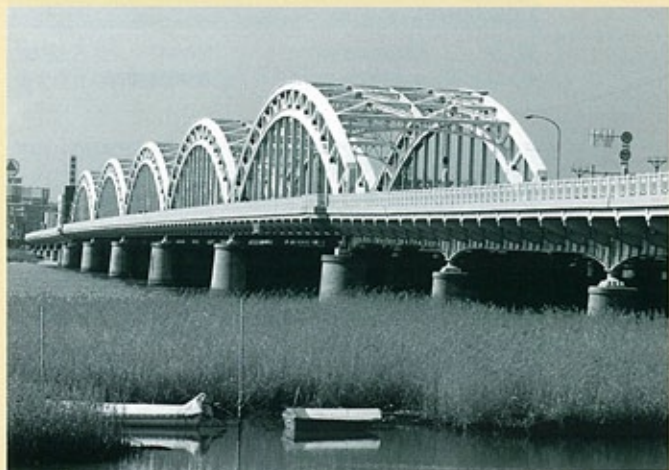
十三大橋 （昭和7年） 淀川に架かる5連のタイドアーチ橋。雄大な淀川の風景とよく調和を保っている。
