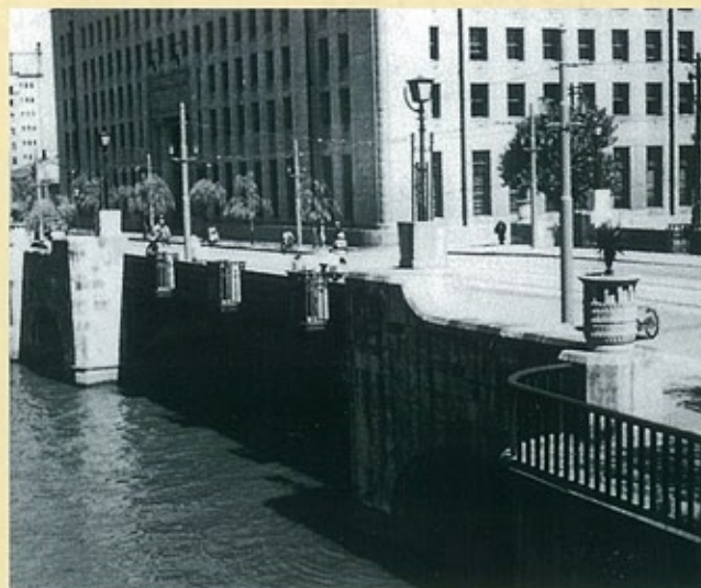
西国橋 （昭和3年） 近接する高層ビルとの調和を考慮して設計された2ヒンジ鋼アーチ橋。西横堀川の埋立てにともない姿を消した。
