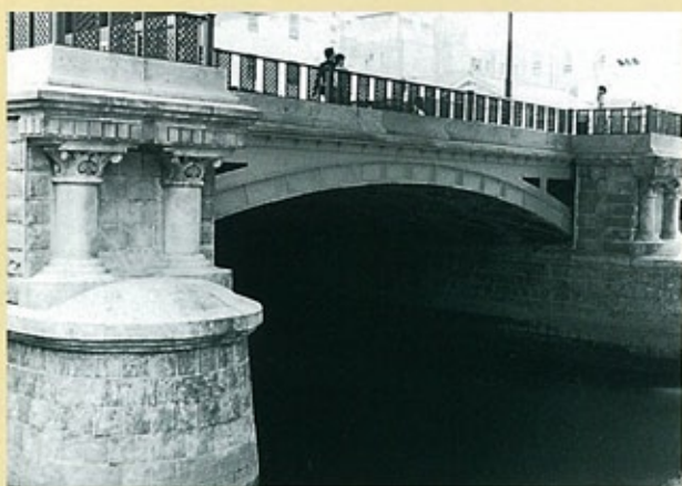
本町橋（大正2年） 2ヒンジ鋼アーチ橋。現存する市内の橋のうちで最も古く、橋台、橋脚の装飾が美しい橋である。
