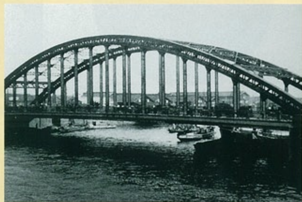
大正橋（大正4年） 市電事業により建設された自動車・市電併用橋。当時国内最大であったスパン90.6mの大アーチ橋も、昭和49年、現在の大正橋に架け換えられた。
