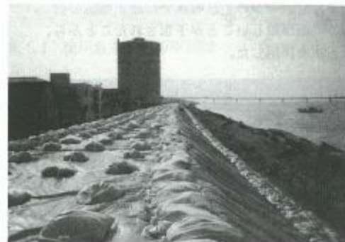
写真5.3.1 第一次緊急復旧工事
