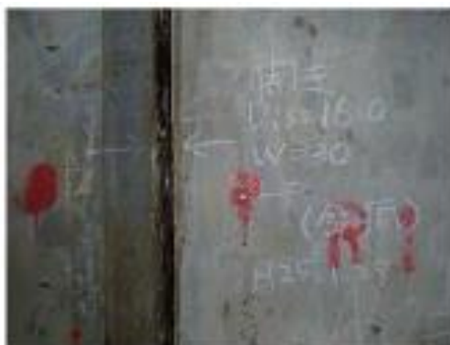
図 6.3.9 道路ボックスの構造継ぎ目の点検イメージ
