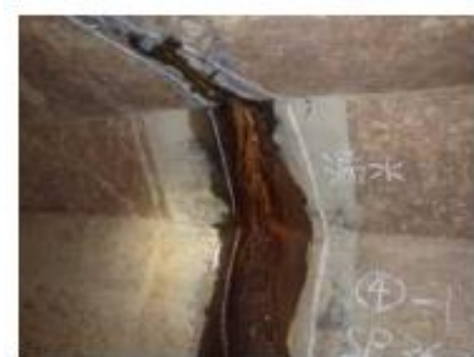
図 6.3.8 函内の漏水イメージ
