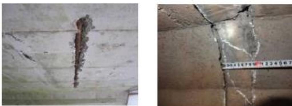
図 6.3.14 躯体の損傷事例
