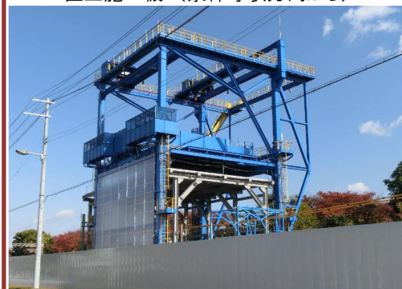
直上施工機 (崇禅寺駅方向から)
