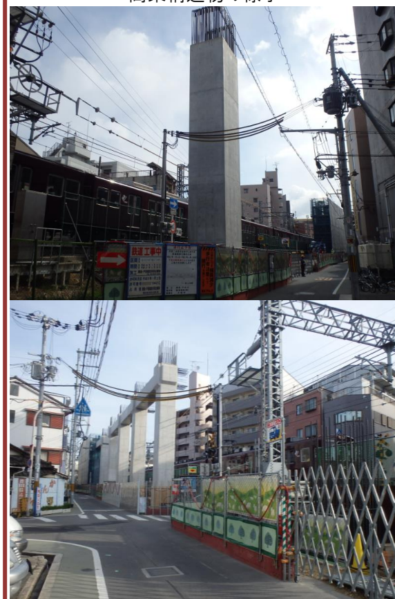
高架構造物の様子
