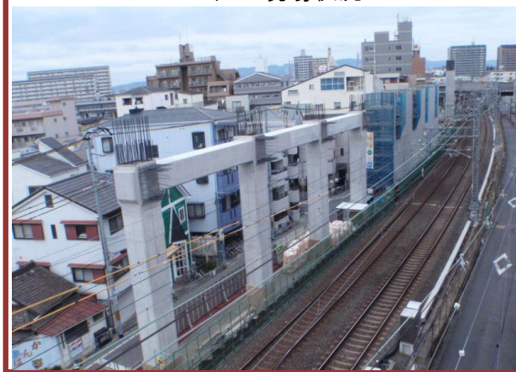
4 工区の現場状況
