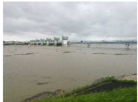
平成25年台風18号により淀川の河川公園等が水没しました。（H25.9.16）
