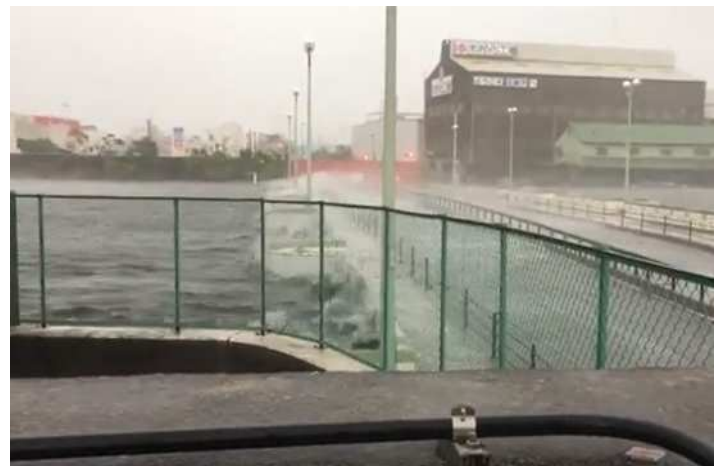
左門橋鉄橋（陸閘）（平成30年9月21号台風） 提供：西大阪治水事務所
