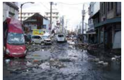
石巻市中央2丁目付近の被害状況
