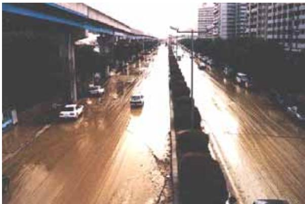
写真 1 液状化現象の一例（車道部）
