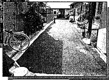
狭あい道路 整備後
