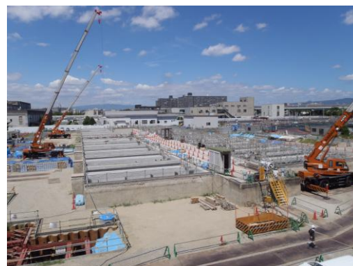
浄水施設（急速ろ過池）の耐震整備
