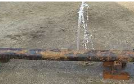
①水道管から水がもれている場所を発見！
