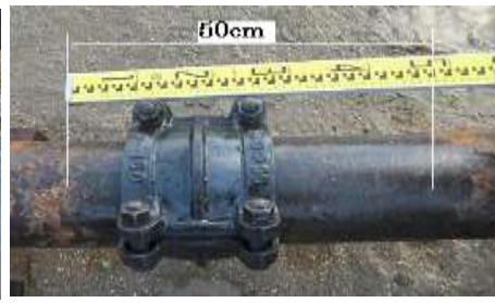
③割継輪（わりつぎわ）を固くしめて、水もれを防止します。これで修ぜんできました。
