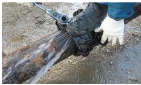
②「割継輪（わりつぎわ）」という輪っか状の金具を、水がもれている場所に取り付けます。
