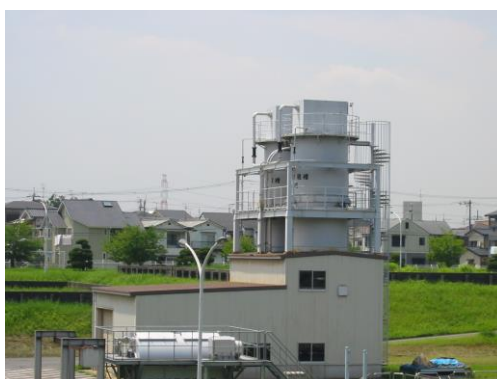
粉末活性炭注入設備（楠葉取水場）
