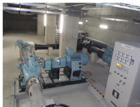
水力発電設備の設置例 （泉尾配水場）
