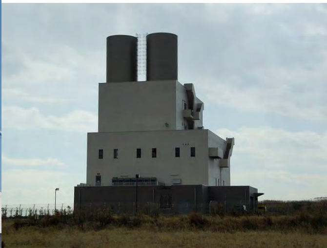
大阪港咲洲トンネル (夢洲換気所)
