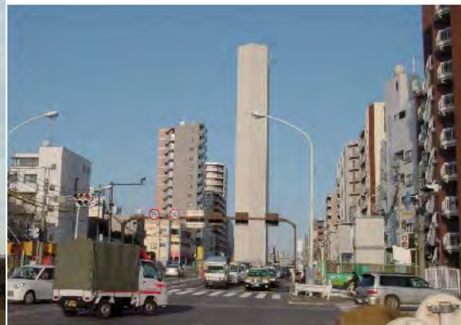
首都高速道路中央環状線 (中落合換気所)
