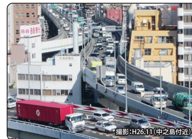
阪神高速 守口線・環状線合流部の交通集中状況
