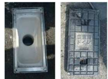
【マンホールトイレ】
