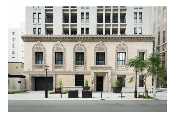
電柱の地中化などプロムナード整備が進む三休橋筋の、中央公会堂にほど近い今橋に建つ高層分譲マンションのグランサンクタス淀屋橋は、1918年に建てられた銀行建築の敷地に、2013年に竣工した。建築家・辰野金吾率いる建築事務所が設計した当初の銀行は、赤いレンガ壁のいわゆる辰野式でデザインされていた。しかし10年後に建築家・國枝博によって大規模な改修工事が行われ、繊細で濃密なアラベスク模様のテラコッタの外観に一新された。マンションへの建て替えに際しては、その外壁を曳家工法で移動させて活用している。(高岡伸一)
