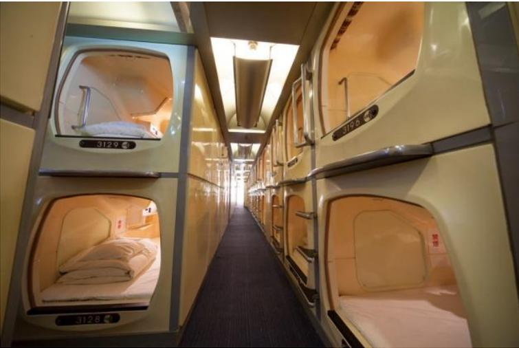
「カプセルホテル」は大阪から始まった。スリープカプセル一つの大きさは、奥行き190cm、幅90cm、高さ90cm。極小の空間に寝具をはじめ、時計・ラジオ・テレビまでも収めている。工場で一体成形されるスリープカプセルは外殻自体に十分な強度があるため、持ち込めば空間を宿泊施設に変えることができる。発案したのは、大阪でサウナを経営していた中野幸雄。快適な宿泊施設を安価に提供できないかと考え、大阪万博で目にした「住宅カプセル」の設計者である黒川紀章に設計を依頼した。黒川らしい曲線的なデザインを家具メーカーのコトブキが実現、1979年に開業した「カプセルイン大阪」を皮切りに、カプセルホテルという新たな業態は瞬く間に全国に拡がり、今では海外でも知られるようになった。（倉方俊輔）
