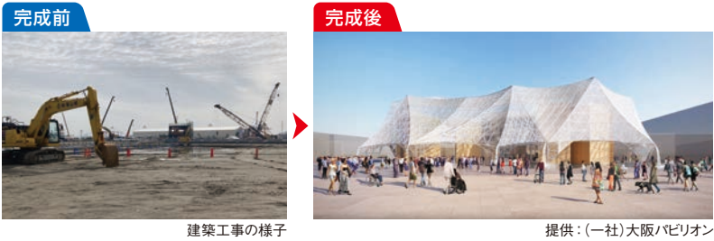
建築工事の様子
