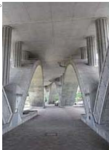
写真■菅原城北大橋のアーチ
