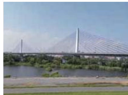
写真■菅原城北大橋全景
