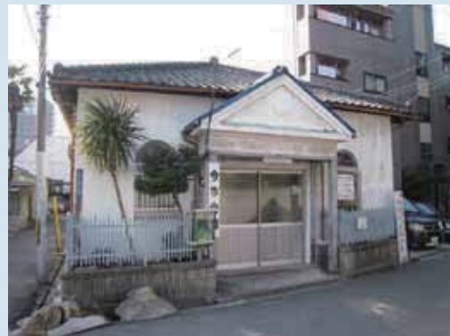
9 今市会館（今市1丁目） 昭和24年(1949)に建てられた、洋風の飾りがあるレトロな建物。
