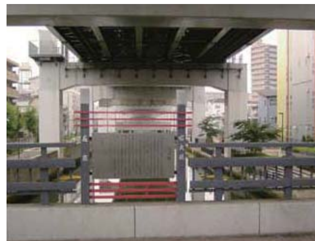
写真■旧街道に架かる懐かしい橋「古市橋」
