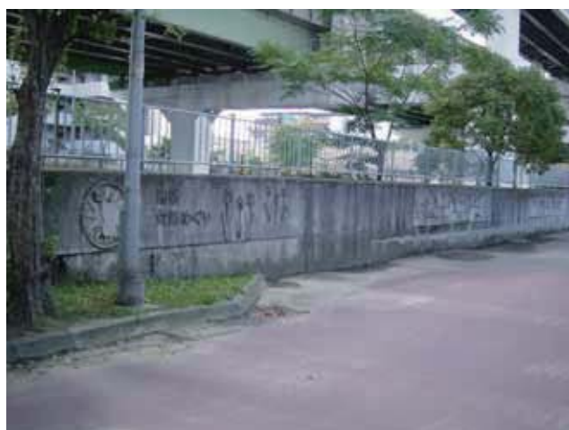
写真■東中宮橋～西中宮橋「旭区史跡彫刻壁画」
