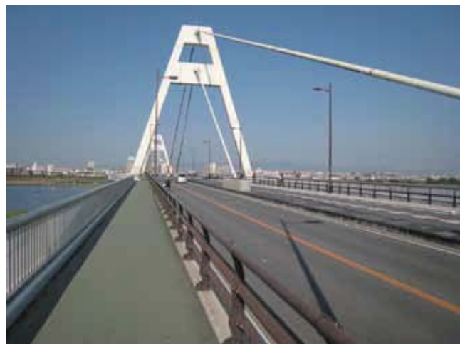
写真■豊里大橋橋上
